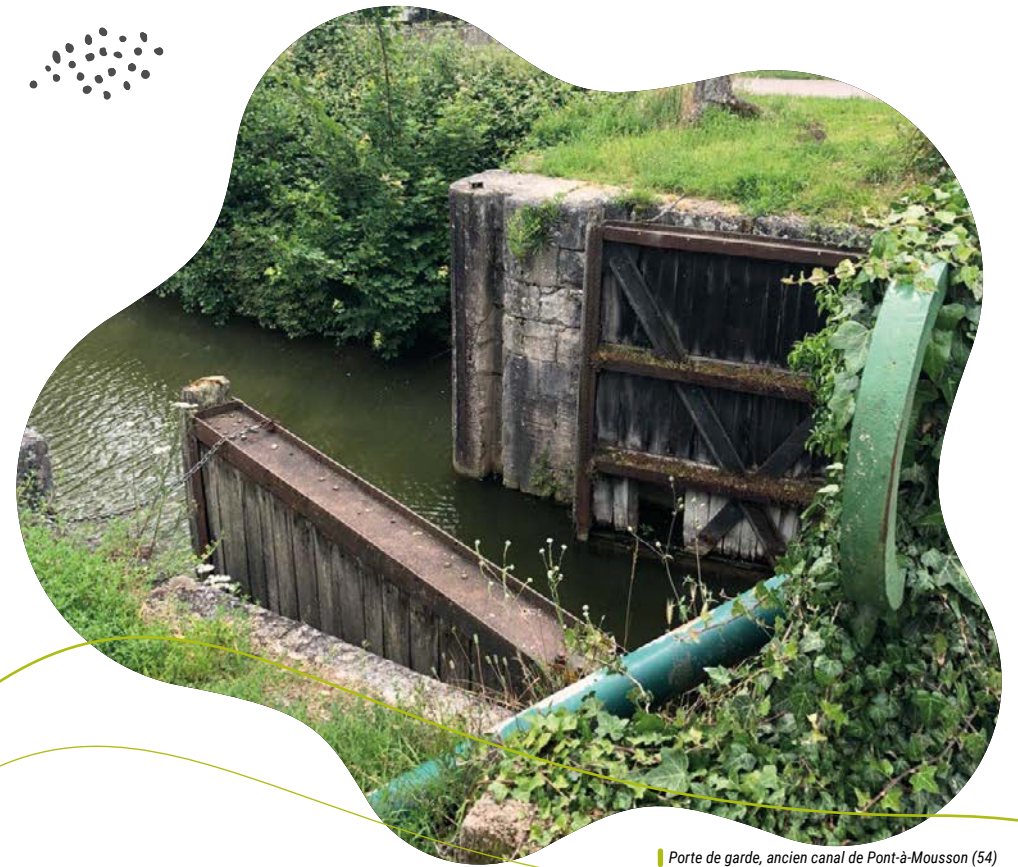
■ Porte de garde, ancien canal de Pont-à-Mousson (54)
